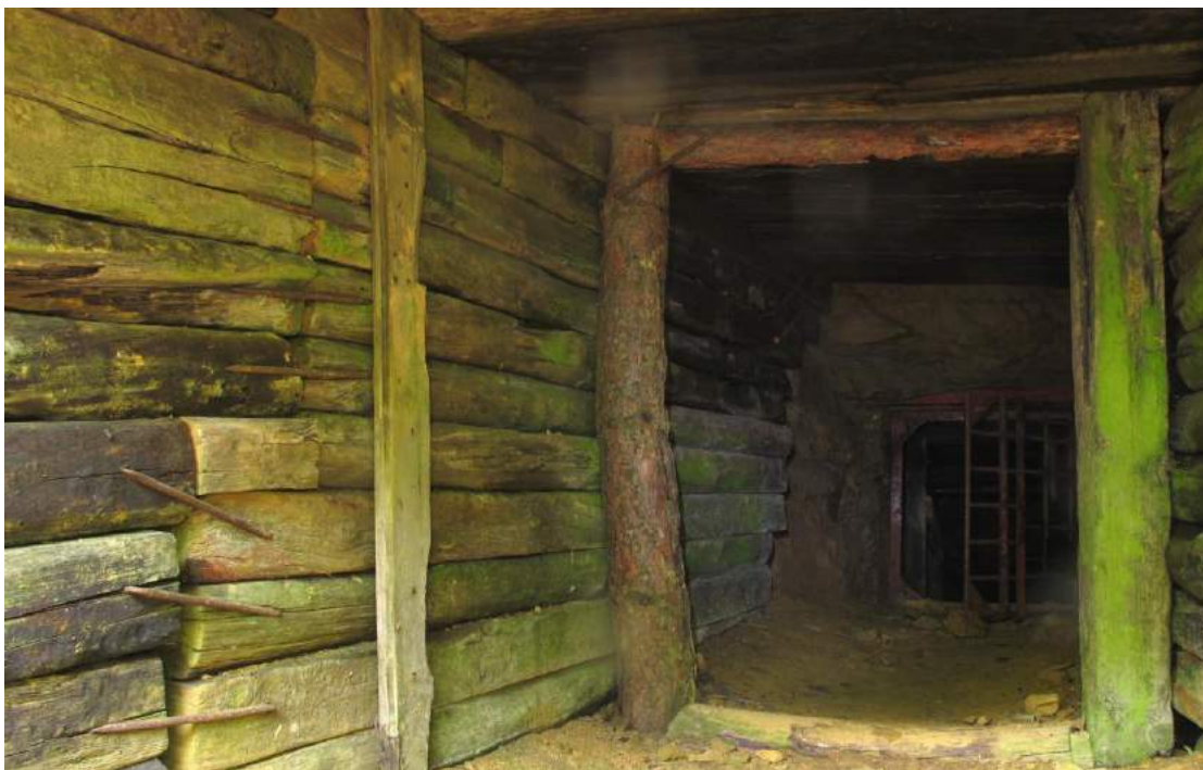
Fot.65. Drewniana obudowa i kratą zamykająca wejście do Podziemi (fot. Aleksandra Adamczyk)
