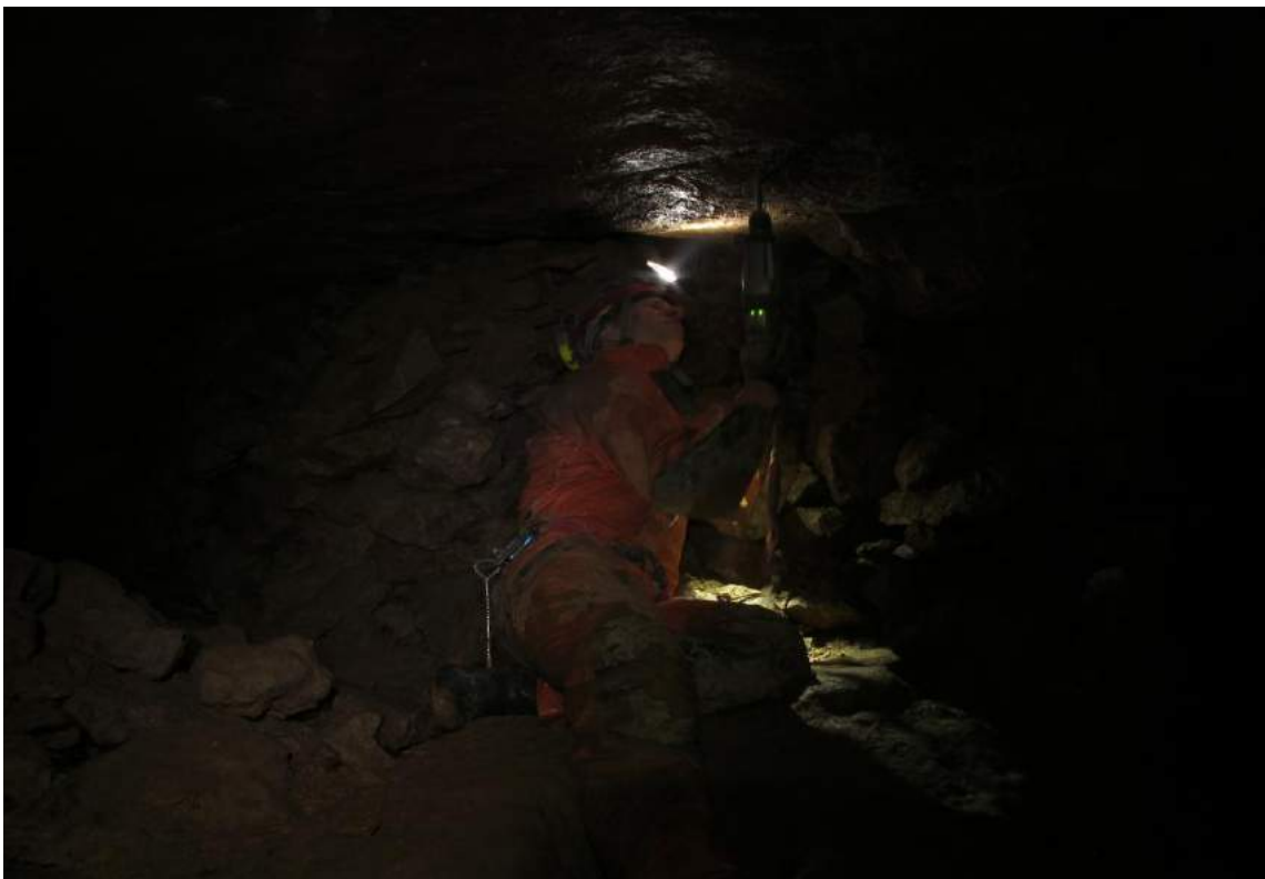
Fot.69. Prace zabezpieczające. Wiercenie miejsca pod ringa. (fot. Aleksandra Adamczyk)
