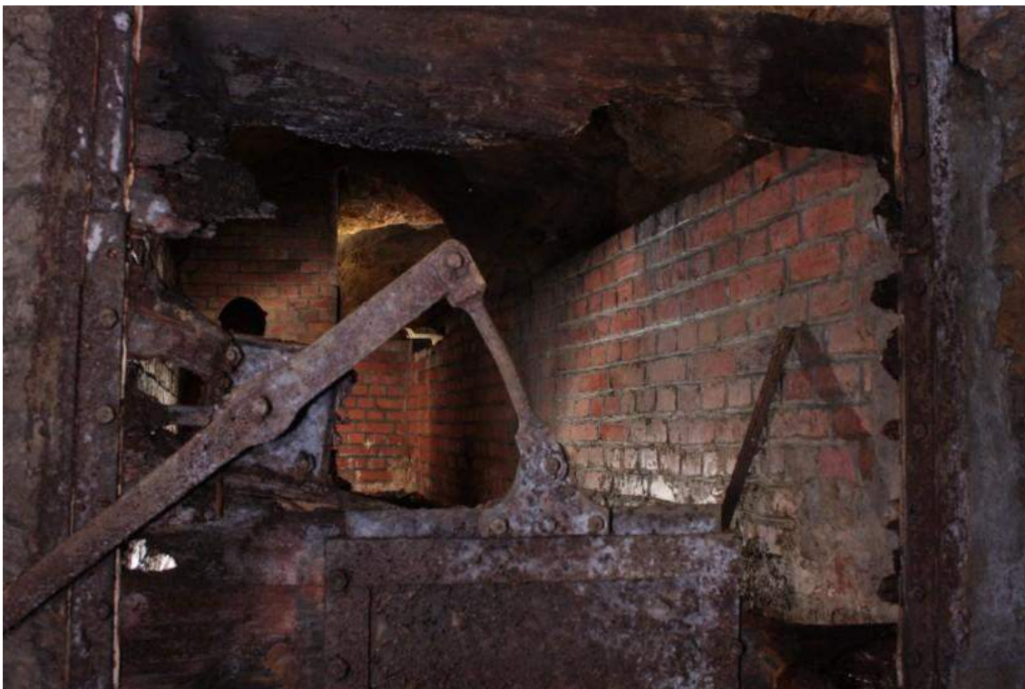
Fot.58. Obmurowana czerwoną cegłą zapora. (fot. Hanna Kullman) NR 26
