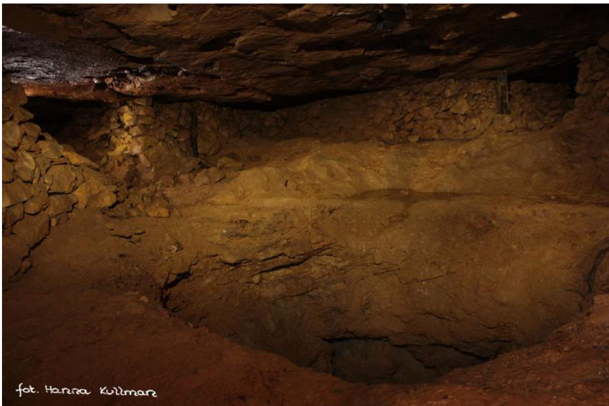
Fot.42. II Studnia - osypujące się kaszty i resztki drewnianych stempli. (fot. Hanna Kullman)
