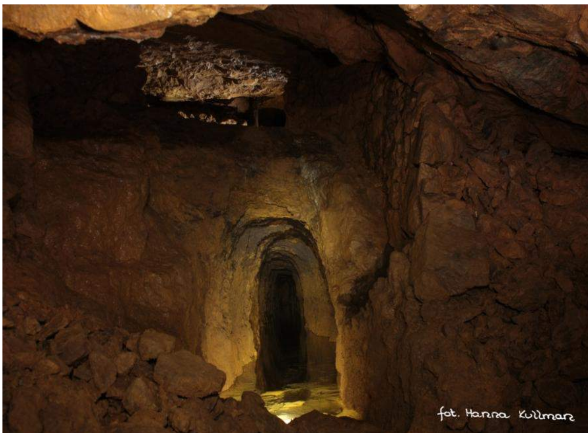
Fot.51. Zalany chodnik przy pochylni (fot. Hanna Kullman) NR 19
