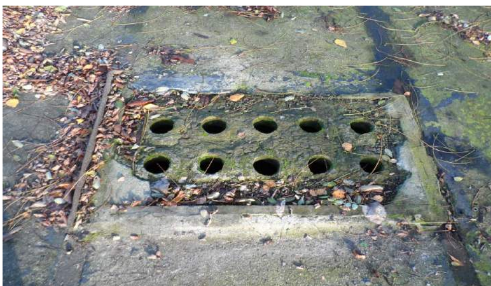
Fot. 68. Otwory wentylacyjne Szybu Glückhilm (Fot. Karol Gładysz)
