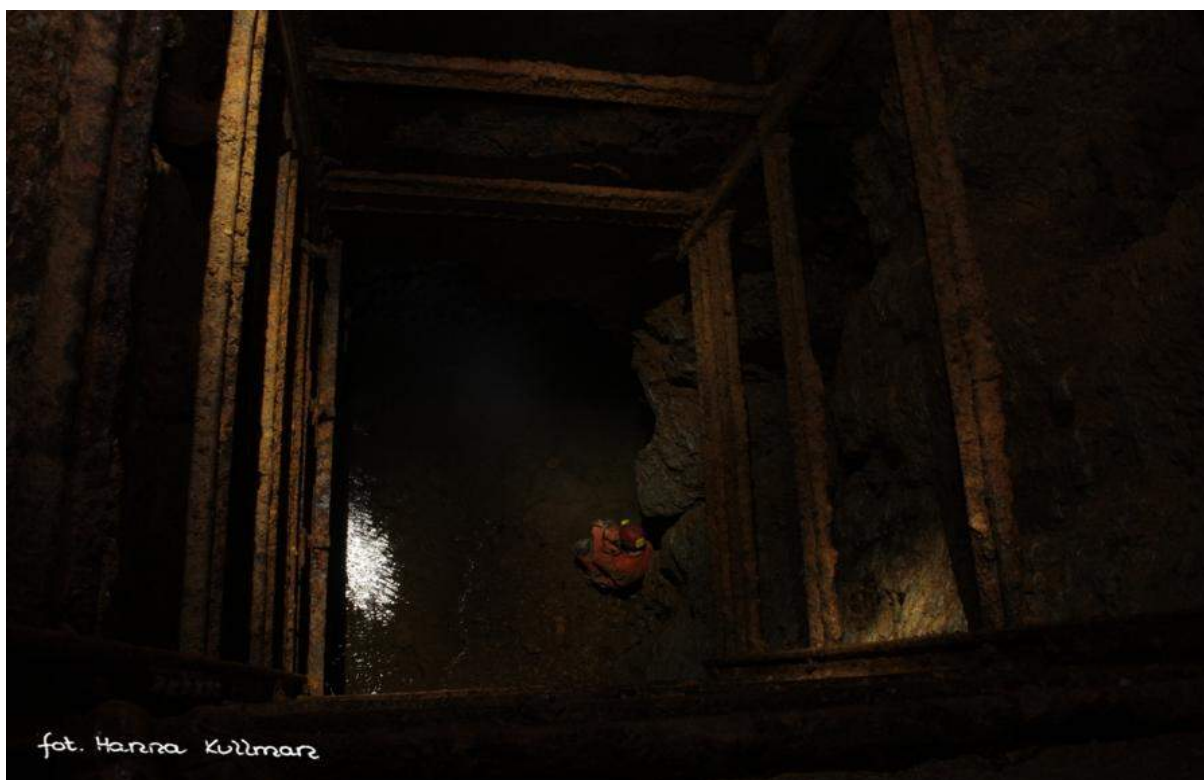
Fot.43. Szyb Urban i jego metalowa obudowa. (fot. Hanna Kullman) NR 12
